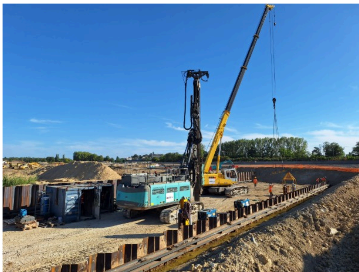
Travaux de génie, construction de la darse
