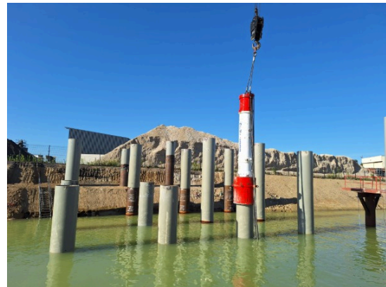
Mise en place des palplanches et vibrofonçage des Ducs d'Albe
