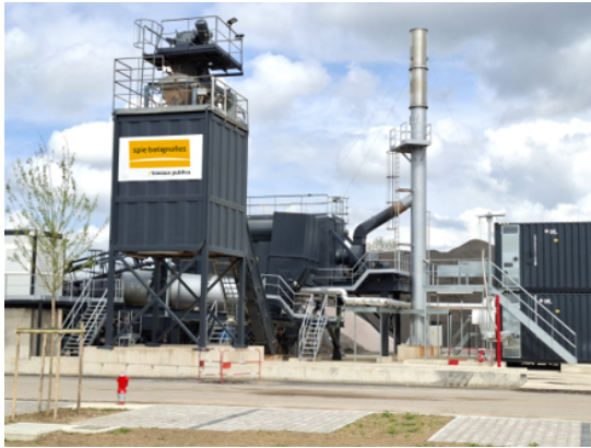
L'approvisionnement depuis la centrale à enrobés située directement dans le périmètre portuaire permet de limiter les parcours des poids lourds et de réduire l'impact carbone lié au transport des matériaux
