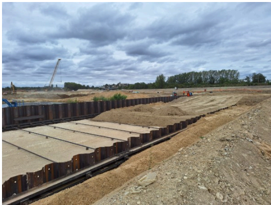
Mise en place des palplanches et vibrofonçage des Ducs d'Albe
