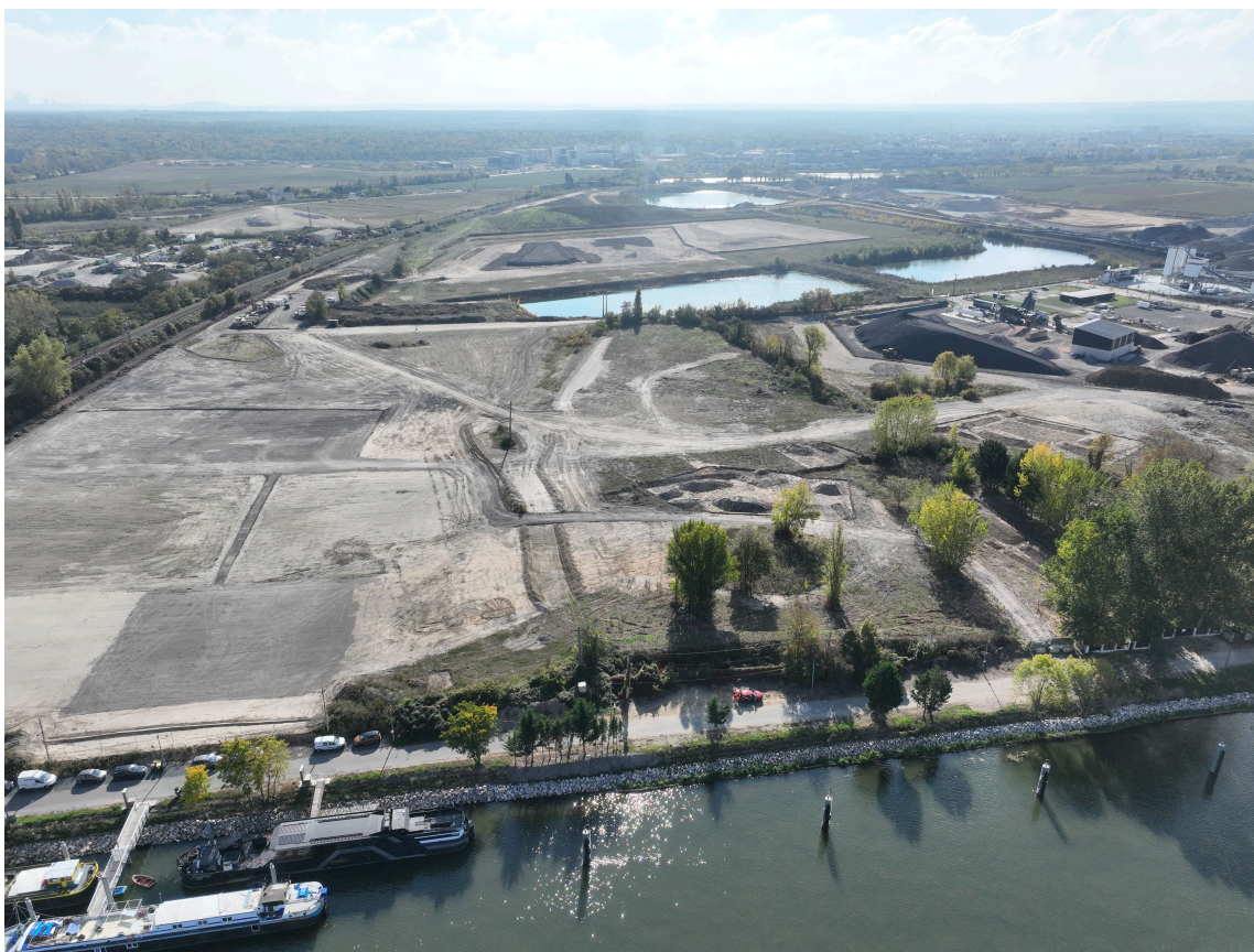
Vue aérienne du site du futur port, captée par drone le 23 mars 2026. Ce dispositif de survol permet de suivre l'avancement des travaux et d'obtenir une vision globale de l'emprise du chantier.
