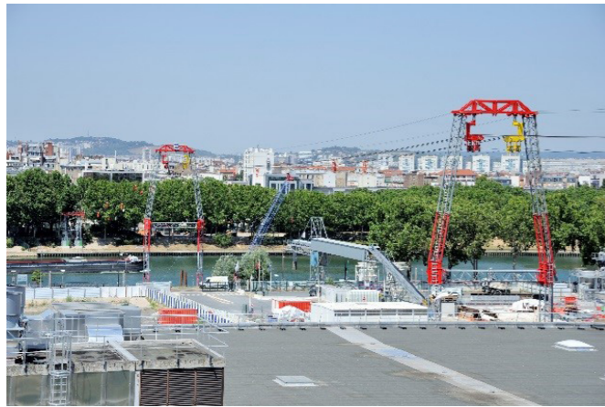
Figure 17 : La ZAC de Clichy (93) évacue les déblais du chantier à l'aide d'un téléphérique allant jusqu'à la Seine (source : VNF)
