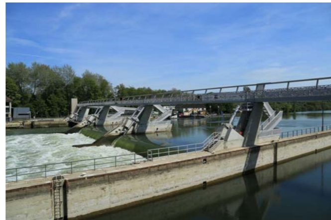
Figure 8 : Barrage de Vives-Eaux (source : VNF)
