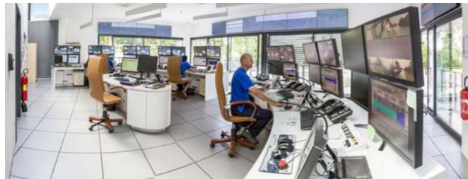
Figure 10 : téléconduite des ouvrages de la Seine-Aval : salle de commande du PCC de Mouy-sur-seine (source : VNF)
