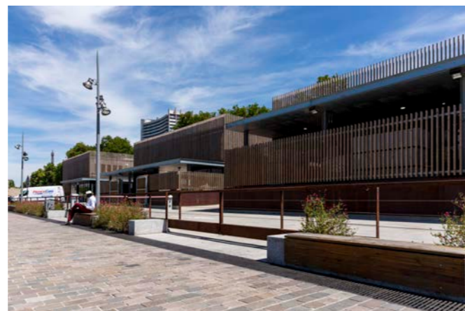
Figure 13 : Port de Javel Bas - Paris 15e : exemple d'aménagement de continuité piétonne et mobilier urbain en bord de Seine avec insertion architecturale d'une agence de distribution de matériaux de construction (source : HAROPA PORT / Laurent Guichardon)
