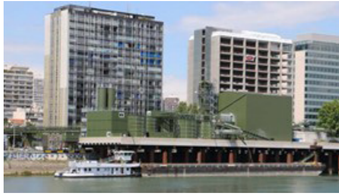
Figure 16 : Centre de tri des déblais de la gare EOLE à la Défense implanté sur la Seine à Courbevoie (92) (source : VNF)
