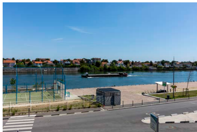
Figure 12 : Port de Choisy le Roi - quai à usage partagé (source : crédit : HAROPA PORT / Laurent Guichardon)
